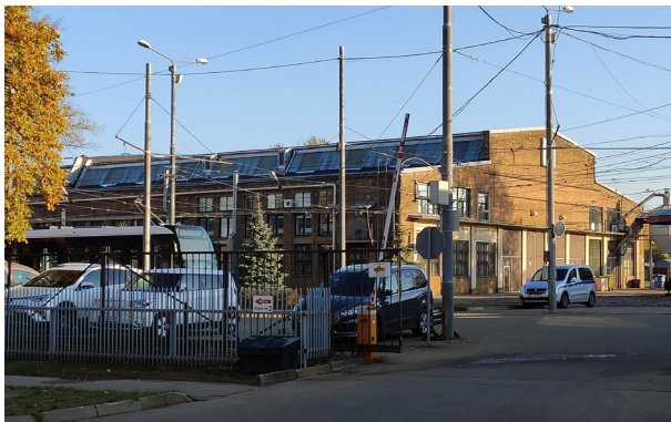
Fig. 16. Workshop for tram carriages at Klijānu iela (address: Brīvības iela 191). Architect Nikolajs Bode. 1939
