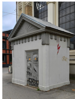
Fig. 19. Small transformer substation, typical design, at the corner of Brīvības iela and Unijas iela. 1922–1929
